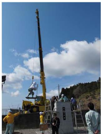
(22) 大型クレーンによる設置
