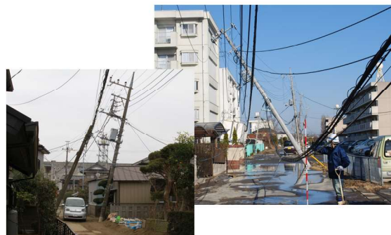
地盤の支持力が低下し、建物・電柱が傾く！
