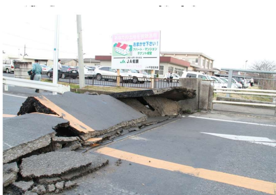
移動した地盤が舗装を押し上げ、通行不能に
