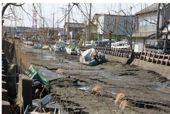
川底が噴砂で隆起して、排水不能に！
