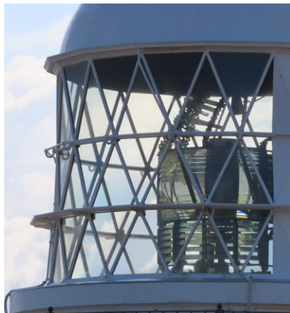
上：地震で上部プリズムが落ちた状態
